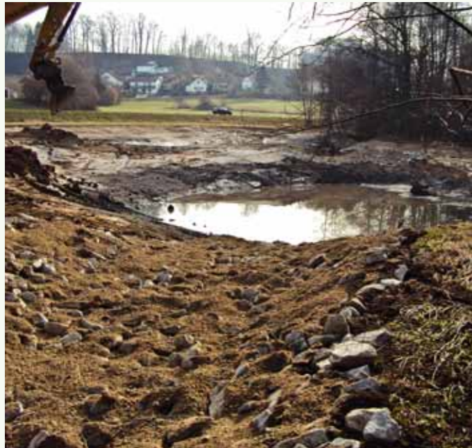
OBEN | Ein Auffangbecken entsteht. Es verhindert, dass der Bach den Schlamm weiterführt.
